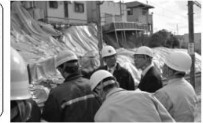
宮本次郎議員は宮本岳史衆院議員とともに三郷町の擁壁崩落現場を視察
